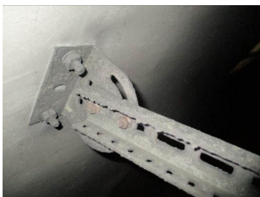
Foto con evidenza della non orizzontalità della canalizzazione nella galleria SchioValdagnopass
