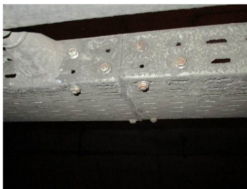
Foto giunzione nella galleria SchioValdagnopass
