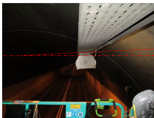
Foto con evidenza della non orizzontalità della canalizzazione nella galleria SchioValdagnopass
